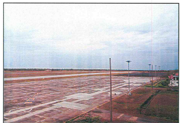
สถานที่ติดตั้งอุปกรณ์เครื่อง AWOS
